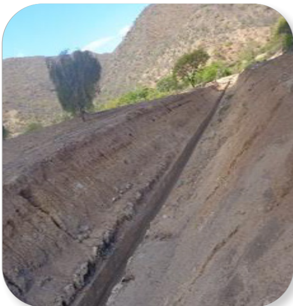
Foto 5. Recorriendo el canal que alimenta a la represa
