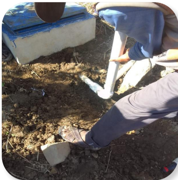
Foto 1. Beneficiarios colaborando con el armado del cabezal del sistema de riego.
