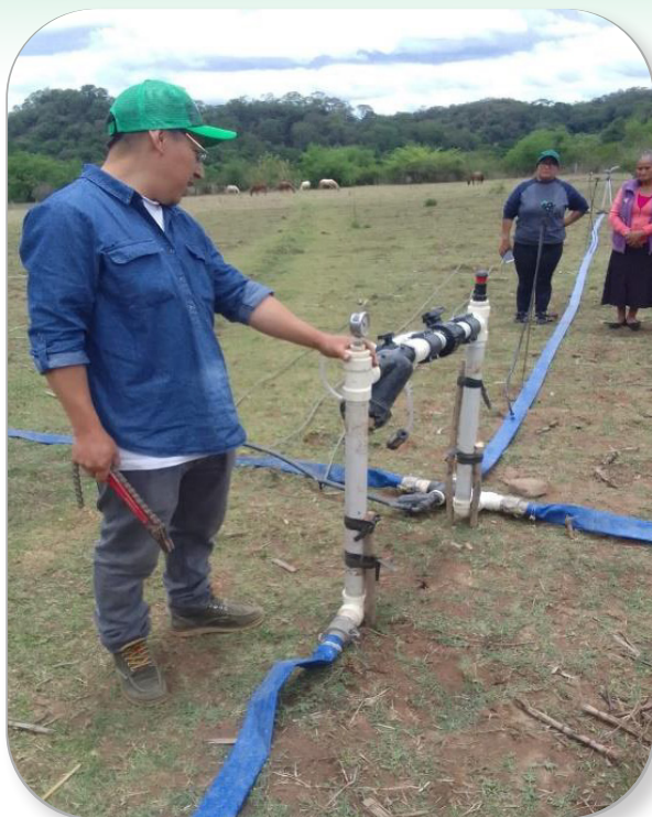
Foto 5. Explicación de la importancia sobre el cabezal del sistema de riego a cargo del técnico de SEDERI-CH
