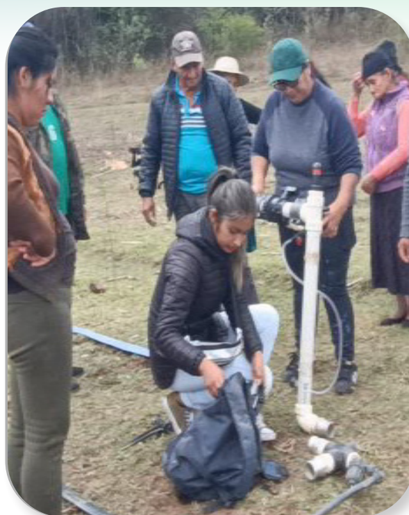
Foto 10. Armado del cabezal del sistema de riego De riego
