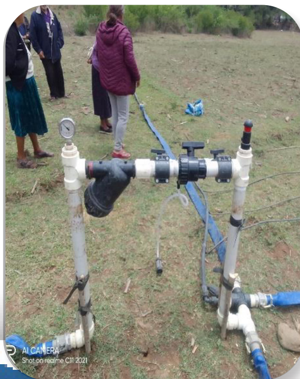
Foto 4. Armado del cabezal del sistema de riego
