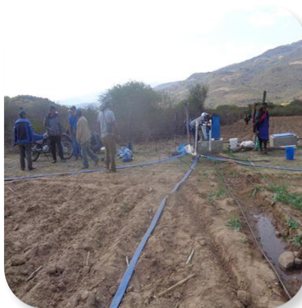
Foto 2. Armado de los sistemas de riego por aspersión y goteo
