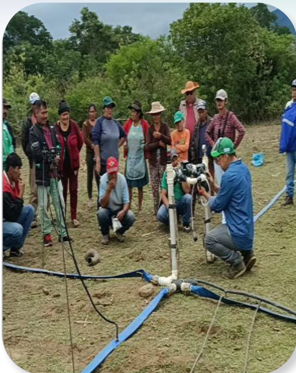
Foto 9. Explicación sobre el filtro del cabezal del sistema del sistema
