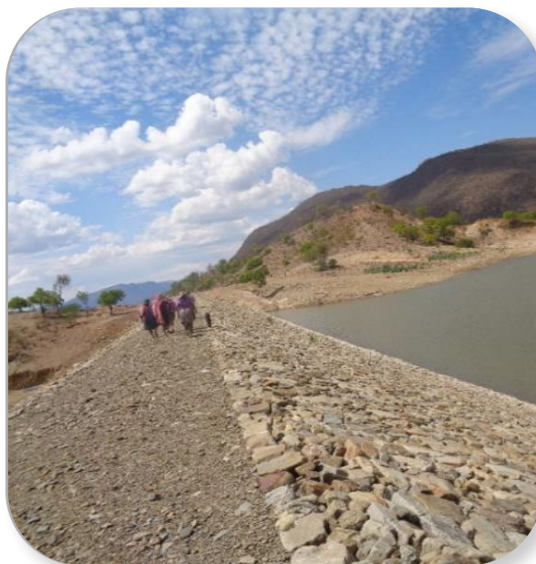
Foto 2. Llegando a la represa para la inspección de campo.
