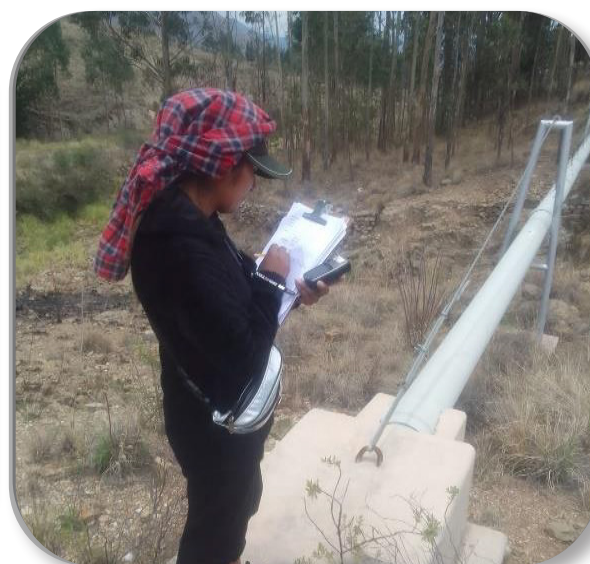
Foto. – 4 Técnico SEDERI-CH georreferenciando la matriz principal del sistema de riego
