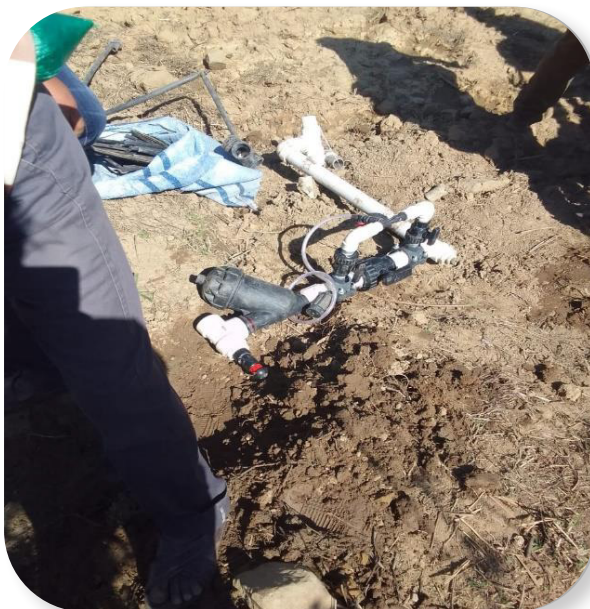
Foto 3. Armado del cabezal del sistema de riego
