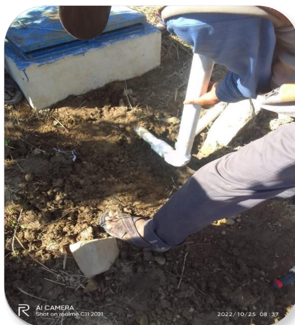
Foto 2. Beneficiarios colaborando con el armado del cabezal del sistema de riego.
