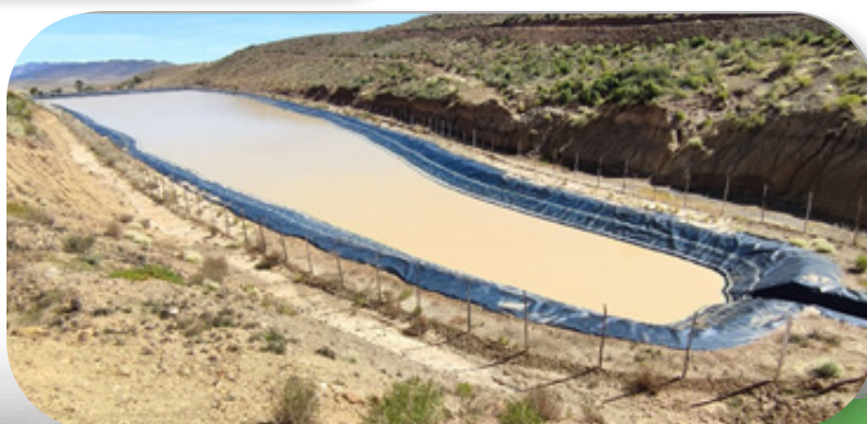
Represa de Villa Verde con geomembrana, donde se realizó la capacitación en Manejo de Cuencas.
